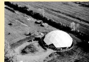
Dôme en 1953 : Avant la construction de l'autoroute transcanadienne et la relocalisation du chemin de Senneville
